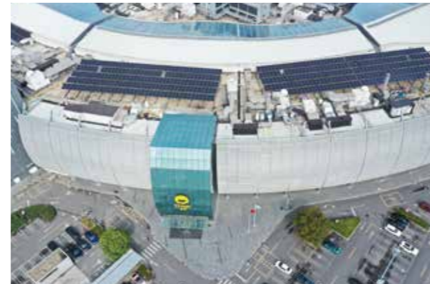
无锡锡山 无锡宜家荟聚532.95kW
