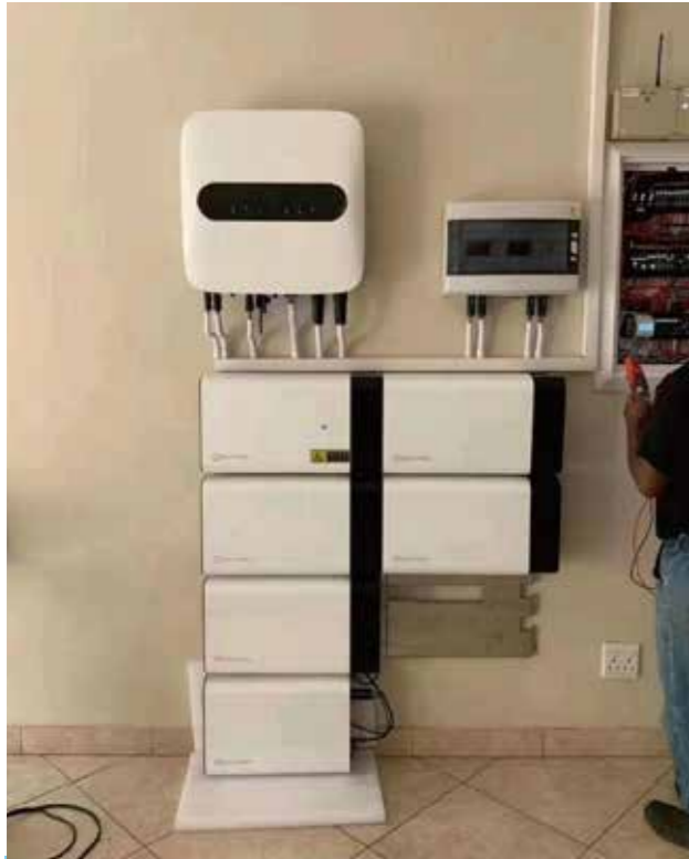
塞浦路斯 15kW/30kWh (锂电)
