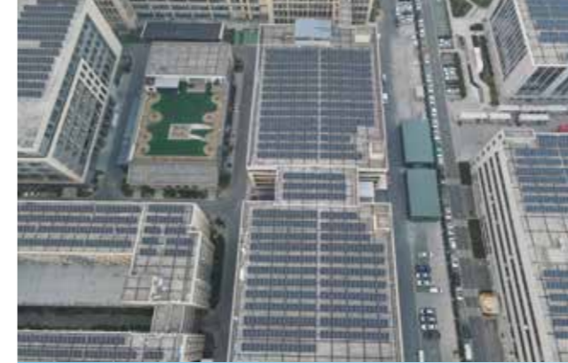
苏州吴中 赛腾1MW水泥屋顶
