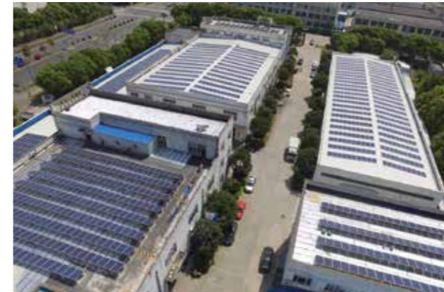
无锡锡山 宝尔森444kW混合屋顶
