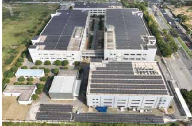
无锡锡山 安普瑞斯 2MW水泥屋顶+车棚 (美企)
