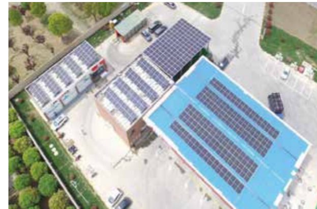
常州武进 中石化125kW加油站
