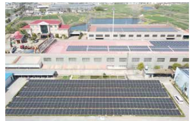
扬州高邮 亿丰光电844.23kW YANGZHOU-844.23kW
