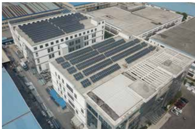
苏州吴中 新泽310kW工业厂房
